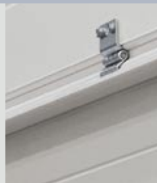
Vartų plokštės sustiprinimas
