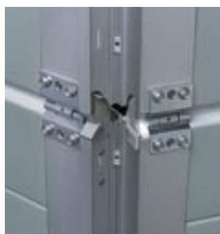
Iš visų pusių einanti vyrių juosta yra nepastebimai integruota durų rėmuose
